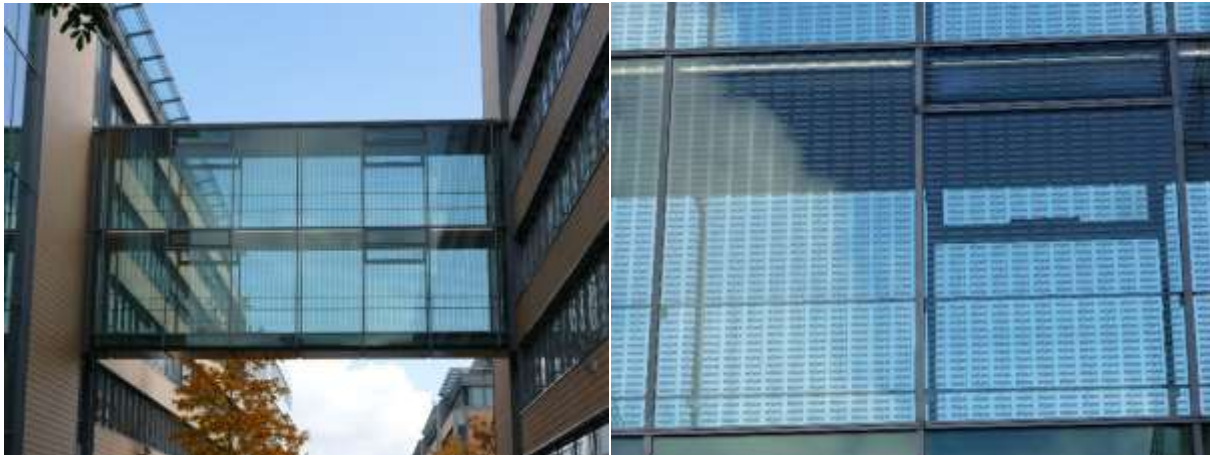
Abb. 58, 59. Glasbrücke Münchner Stadtwerte mit Schutzfolie gegen Vogelschlag (Fotos: D. Bornemann)
