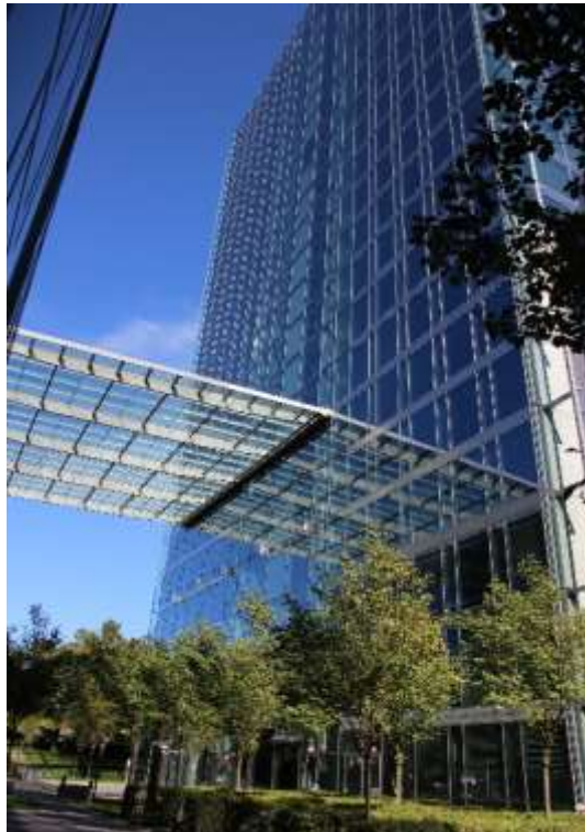
Abb.27. Osram-Hochhaus und gläsernes Vordach (Foto: E. Wölf)
