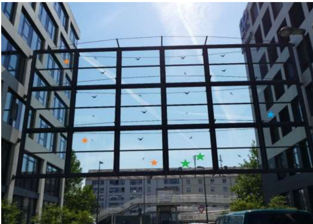
Abb. 25: Glaswand Ludwig-Hilberseimer-Str. – die Sterne markieren Vogelabdrücke (orange: vorgefunden bei der Ersterfassung am 7.8.20;* blau: 7.9.20, grün: 21.9.20) (Foto: D. Bornemann)
