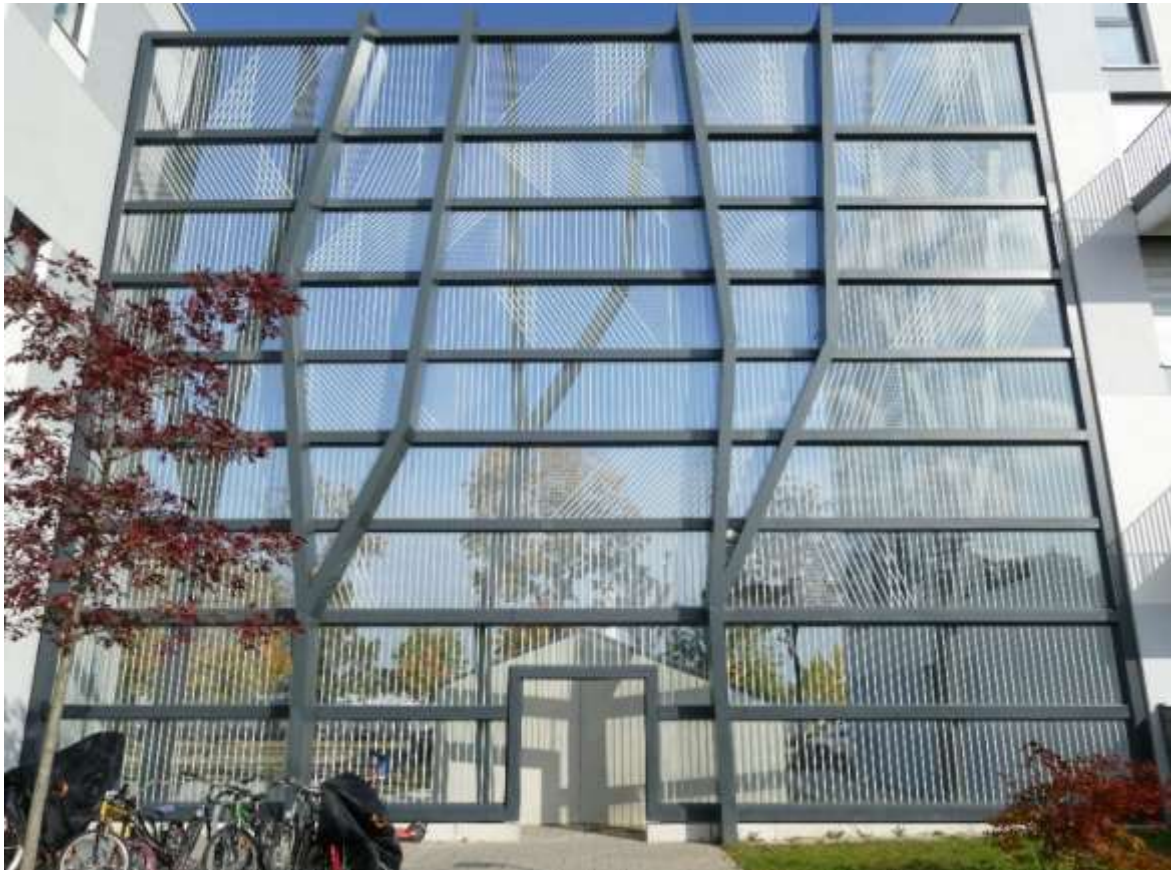
Abb. 36. Schallschutzwand am Frankfurter Ring – für Vögel ein deutlich erkennbares Hindernis (Foto: D. Bornemann)
