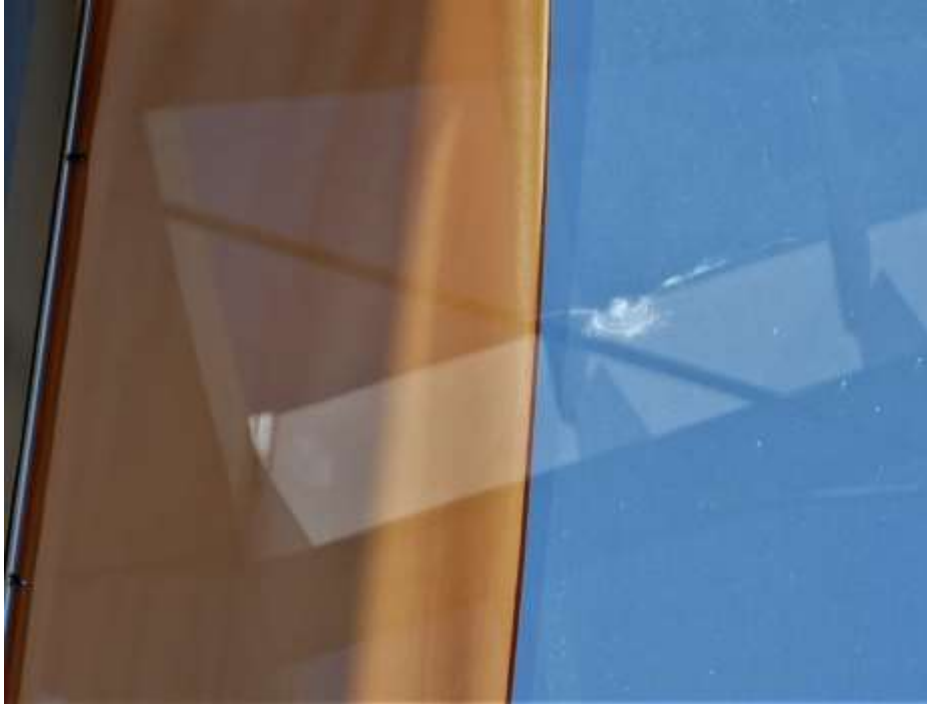
Abb. 48. Abdruck eines taubengroßen Vogels direkt neben der zum Vogelschutz angebrachten Stoffbahn (Foto: D. Bornemann)
