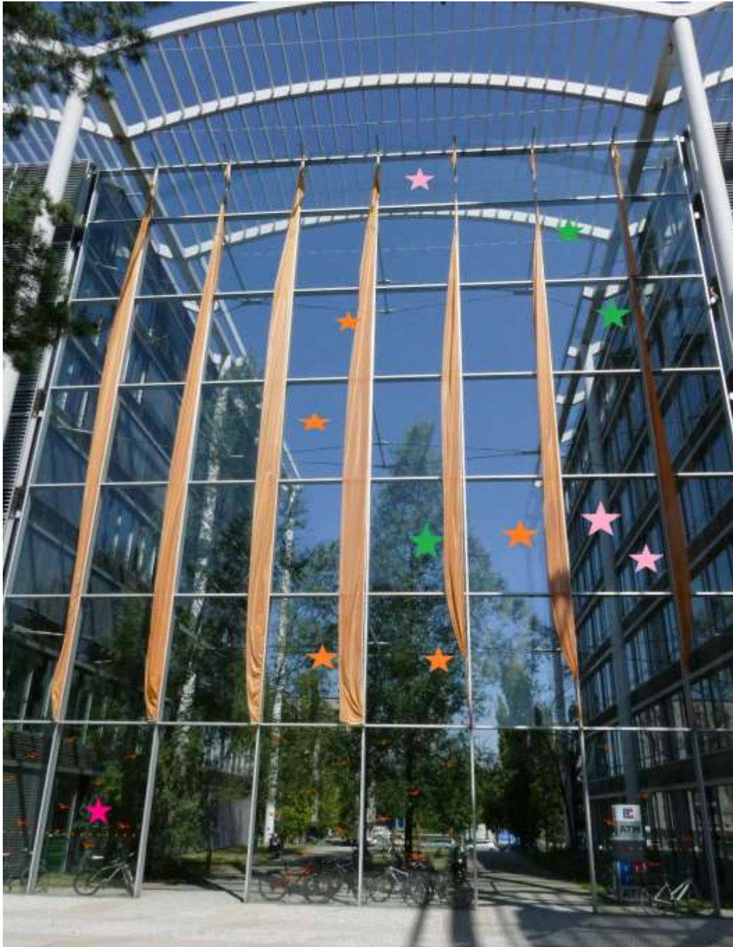
Abb. 40: Markierungen der Vogelschlagabdrücke an der Glaswand Georg-Brauchle-Ring 60-62 (orange: vorgefunden bei der Ersterfassung am 7.8.20, pink 24.8.20, rosa 27.8., grün 21.9.20) (Foto: D. Bornemann)
