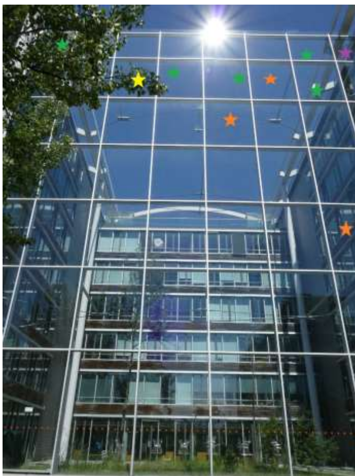
Abb. 51. Markierungen der Vogelschlagabdrücke an der Glaswand Georg-Brauchle-Ring 66 (orange: Ersterfassung am 7.8.20, gelb 19.8.20, grün 21.9.20, lila 28.9.20) (Foto: D.Bornemann)
