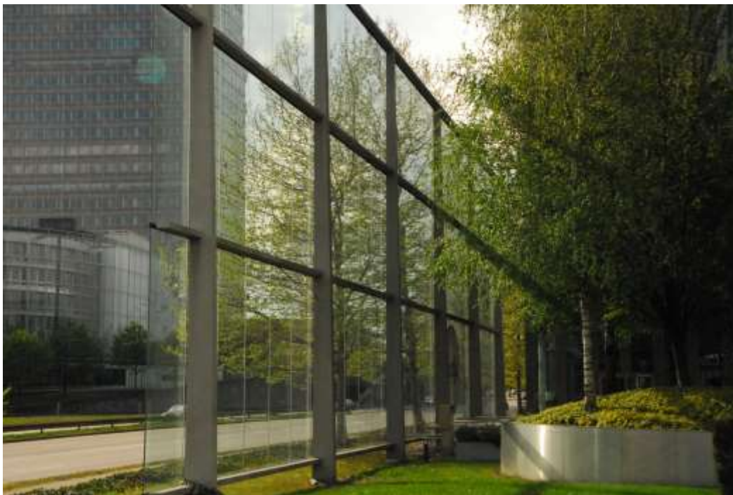
Gläserne Wand am Mittleren Ring bei den Highlight Towers München-Schwabing (Schenkendorfstraße)
