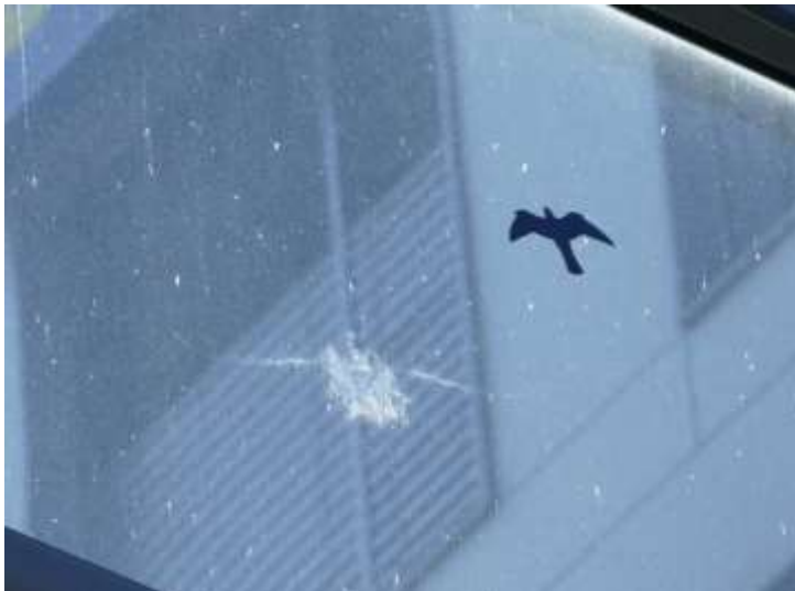
Abb. 62. Abdruck einer Kollision in direkter Nachbarschaft zu einem Aufkleber, Glaswand Ludwig-Hilberseimer-Straße (Foto: D. Bornemann)
